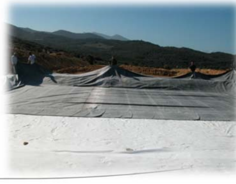
2/ Pose du géotextile et de la membrane
