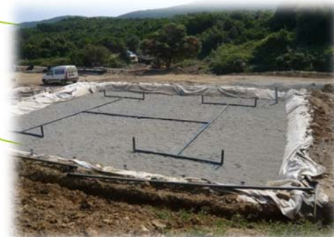
5/ Installation du réseau de répartition des effluents
