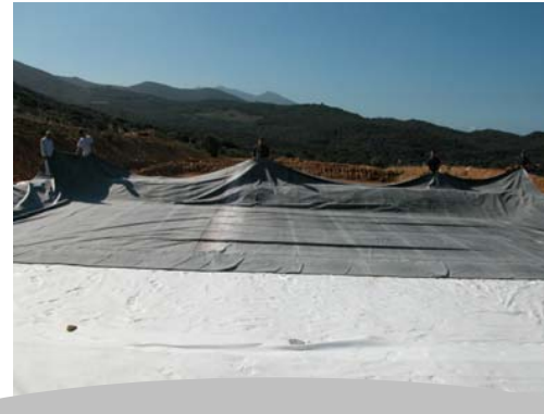
2/ Pose du géotextile et de la membrane
