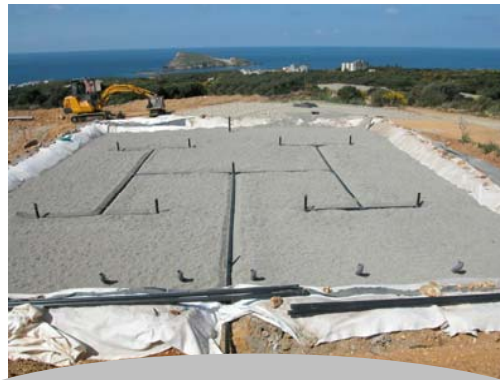
5/ Installation du réseau de répartition des effluents
